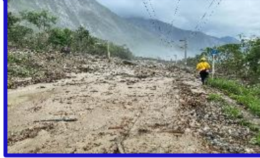
K56+620 土石流掩沒軌道
