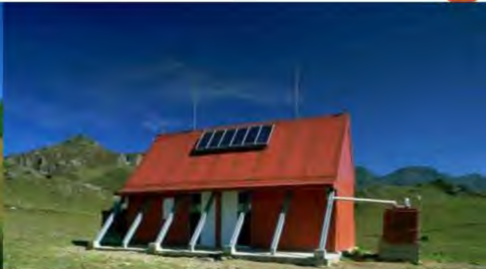
玉山南二段大水窟山屋，太陽能及節水設備
