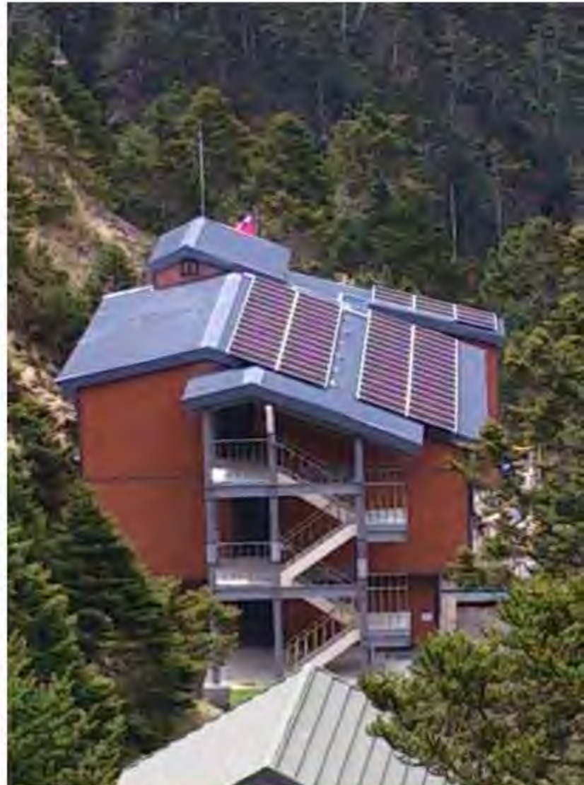
排雲山莊的太陽能板提供基礎電力
