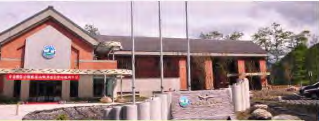
觀霧山椒魚生態中心雨水過濾設備系統
