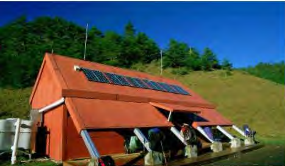
玉山馬博拉斯橫斷馬布谷山屋太陽能及節水設備
