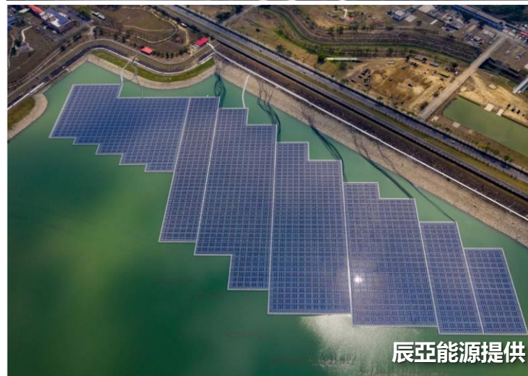
阿公店水庫水面型太陽光電， 設置容量2.3MW，面積約2.3公頃。
