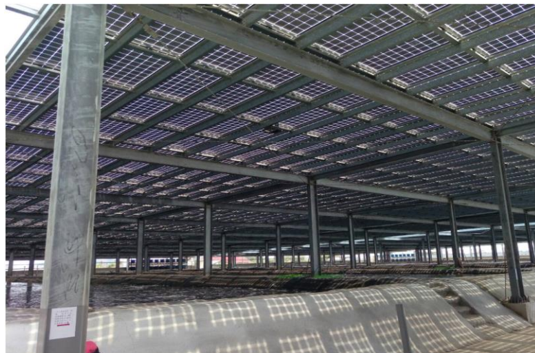
台南市天王能源漁電共生室內養殖場， 設置容量2.86MW，面積約2.86公頃。
