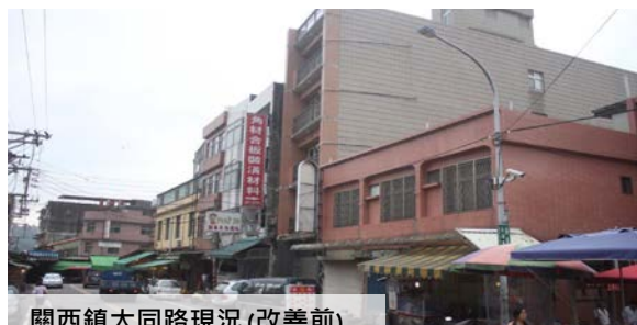
關西鎮大同路現況 (改善前)
