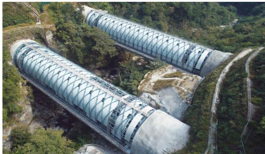
**南澳和平段-鼓音橋**採鋼結構設計，串聯觀音及谷風隧道成為12.6公里的長隧道，國內僅次於雪山隧道12.9公里。
