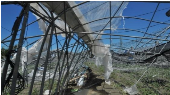
結構連接件與補強設計不佳
