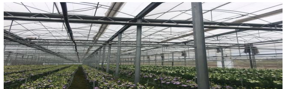
鋼骨結構加強型捲揚式塑膠布溫室
