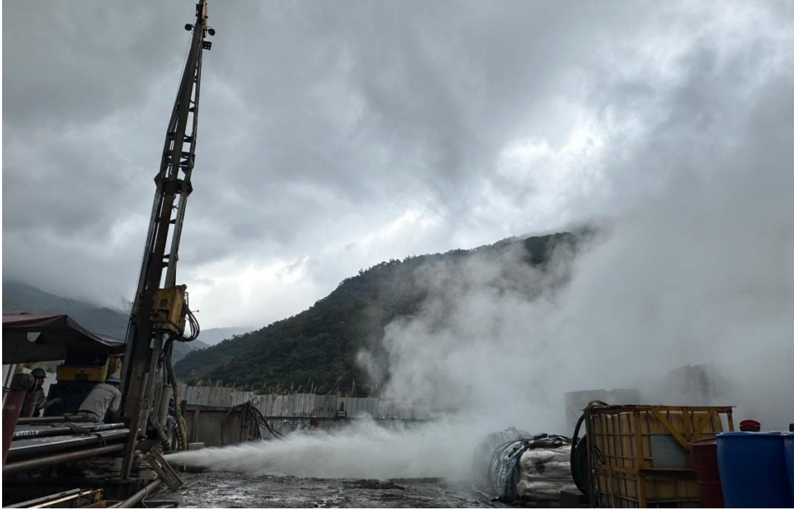
圖 4-6 花蓮瑞穗 2 號井因地下高溫(175°C)導致之間歇性高壓水汽噴發現象
