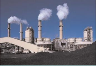
加強大型排放管道 管制
