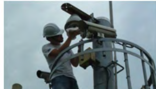
CCTV 監視站檢測
