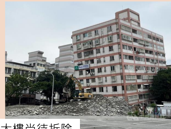
富凱大飯店、統帥大樓尚待拆除
