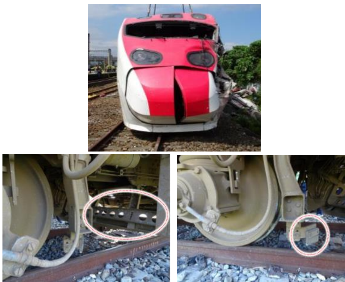
圖 4.1.2-1 事故列車前方外觀及排障器無撞擊異物痕跡
