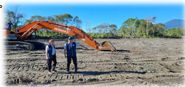
淤泥暫置場整地中
