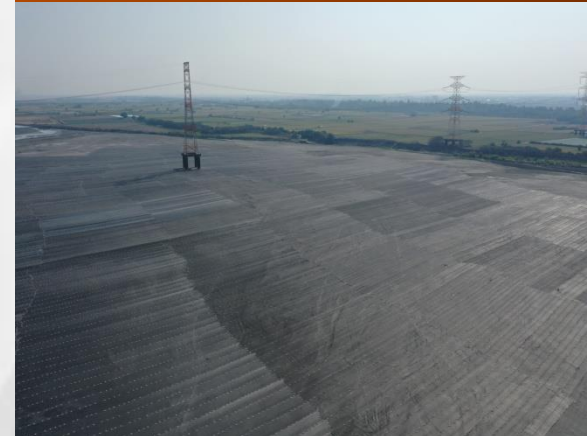
自強大橋下游灘地 平鋪式防塵網35公頃
