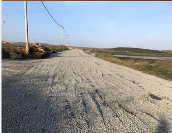
麥寮鄉NO.10越堤路 碎石級配鋪設3.15公頃
