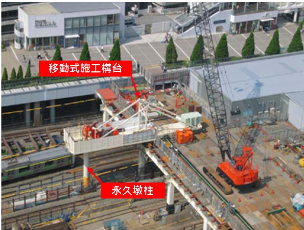
圖 5.2-3 構台向兩側延伸施工示意圖
