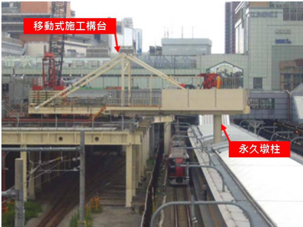
圖 5.2-2 構台向前延伸施工示意圖
