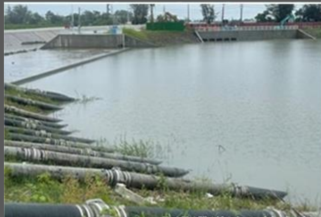
8/4北港滯洪池預排
