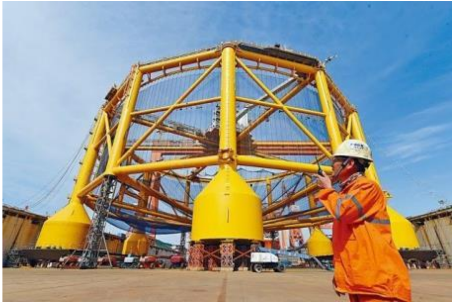
圖 4-7 挪威的大型半沉式海上箱網
