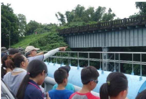
渡槽橋推廣教育現場
