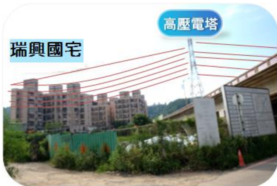
圖 5-1 高壓電纜穿越瑞興國宅
