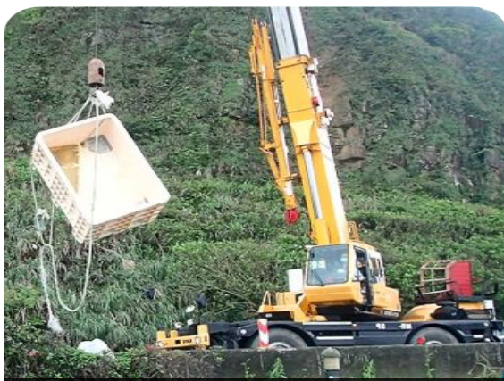
岩岸地形 吊車清理搬運
