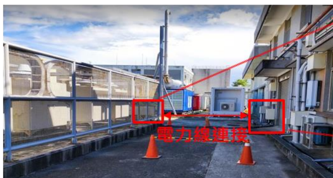
三相功率調節系統與柴油機併聯盤配置
