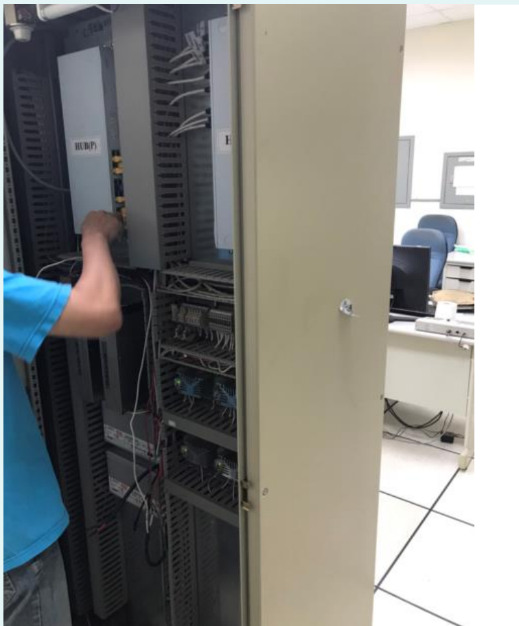
8月15日大潭計量站更換電源供應器施工照片
