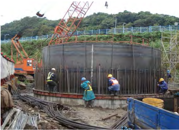
井式基礎(沉箱基礎)施工
