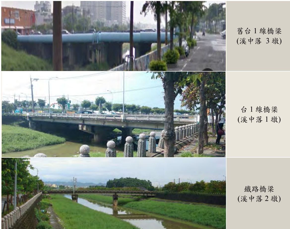
圖 6.2-2 現有橋梁照片
