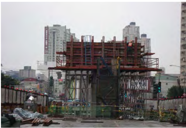
橋墩、帽梁施工
