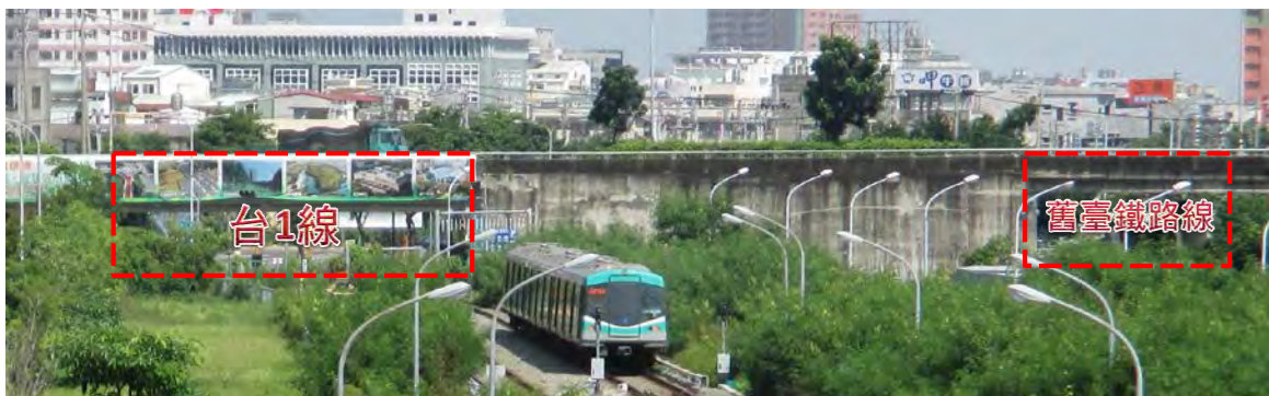
圖 3.3-1 介壽路橋現況照片
