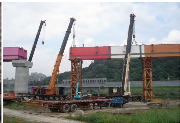
鋼構吊裝作業
