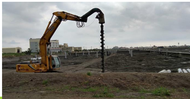
光電立柱基樁施作
