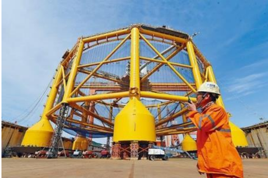
圖 4-7 挪威的大型半沉式海上箱網
