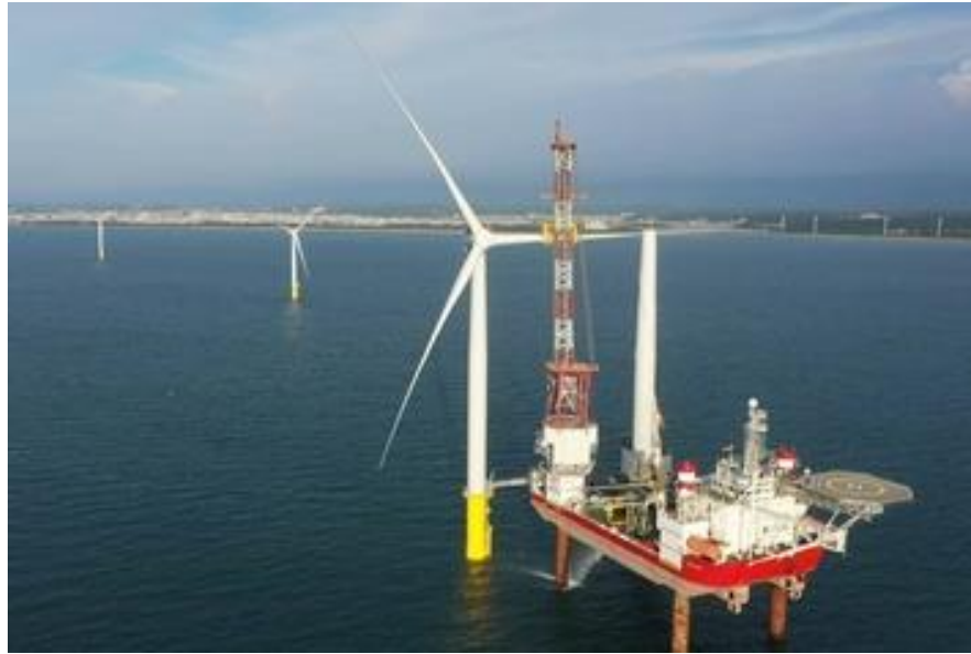
圖 4-9 離岸風機工作船作業狀況
