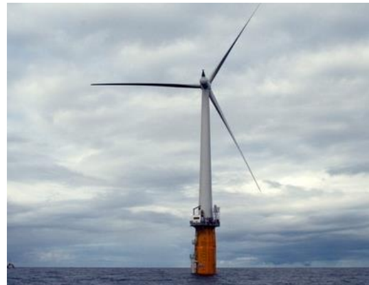
挪威 2.3 MW 浮動式離岸平台，2009
